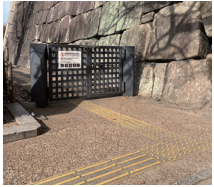
地上エレベーター入口
